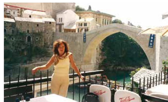
▲ Елена Солодовникова. Мост отстроен заново. Скоро открытие. 2004 г.
